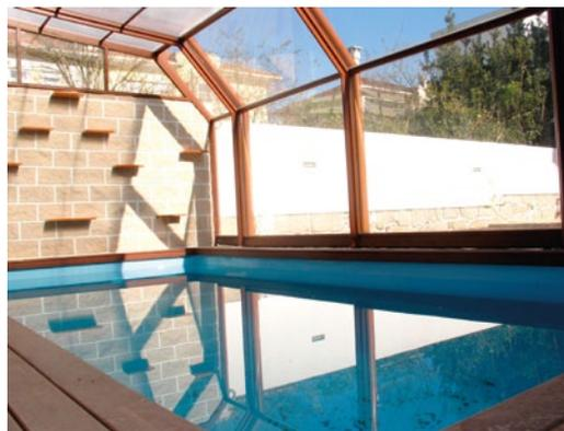
De concepção original, esta cobertura alta, 2m no primeiro elemento, com larguras desde os 3.80m até 9.80m, dispõe de um conjunto de calhas-guia que a mantêm apoiada a uma parede ou num pórtico.
